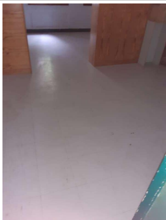
Déclaré - : RDC / PALIER 1 - Dalle de sol - EP- (Présence d'amiante)
