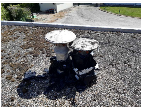
Déclaré - : EXTERIEUR / TOITURES TERRASSE - Accessoire de couverture - EP- (Présence d'amiante)
